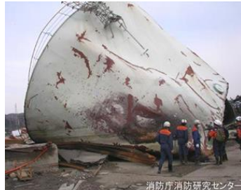
津波によるタンク転倒
