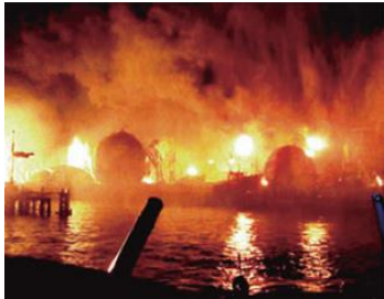
高圧ガス貯槽の爆発火災
