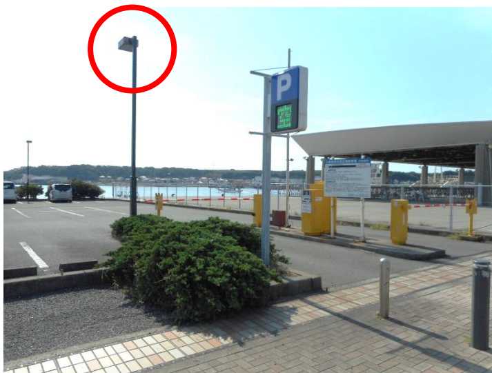
駐車場管理機器と照明(4基)
