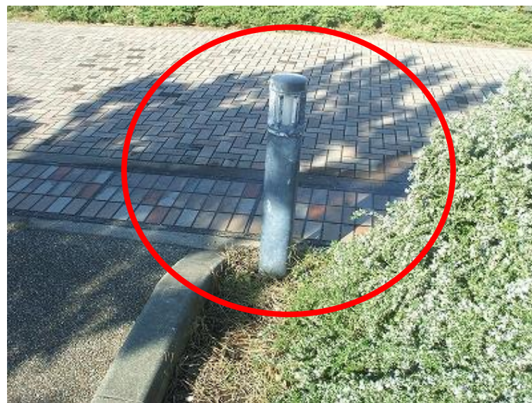
交流広場内照明(4基)
