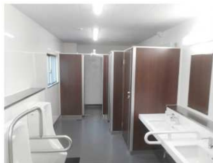
改修工事後（例）
