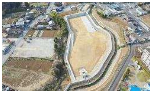
境川風間遊水地（R 3 本体完成）
