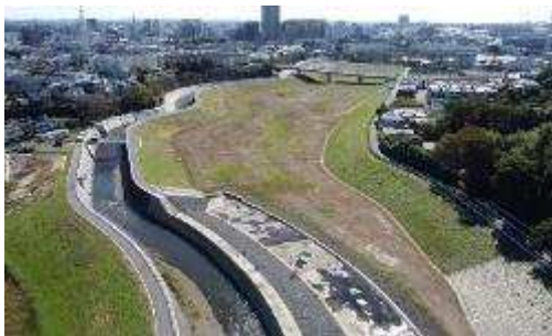
引地川下土棚遊水地（R 2 本体完成）
