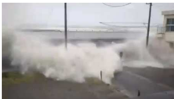
令和元年台風第 19 号における越波状況 (小田原海岸)
