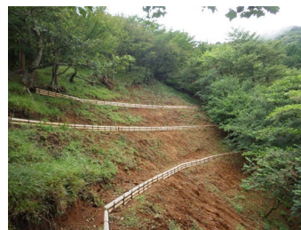
中標高域の自然林の土壤保全対策
