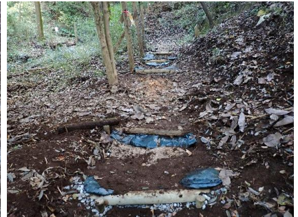
補修後の階段
