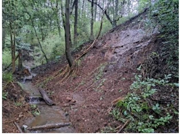
N10付近斜面の崩落
