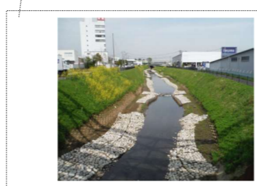
⑥河川・水路における自然浄化対策 自然石による護岸とし、生物の生息空間を確保した。（厚木市恩智川）
