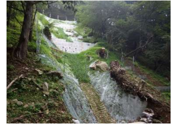
③土壌保全対策 水源林の基盤整備では土木的工法を用いて土壌保全対策を実施した。（秦野市）
