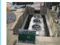
一般家庭への浄化槽設置
