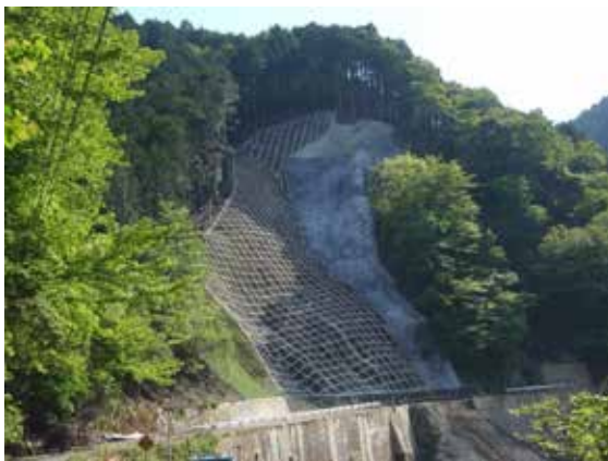
山腹工施工地（山北町）
