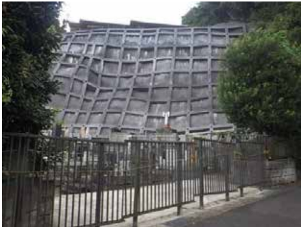
法面防災工事（鎌倉市）
