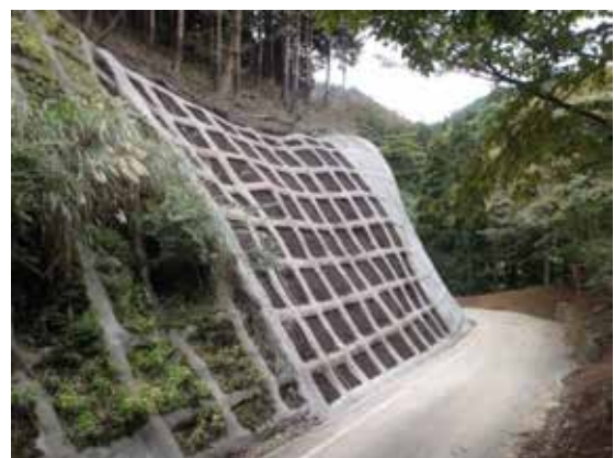
唐沢林道 法面保護工（清川村）
