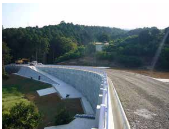
工事完了(舗装前)
