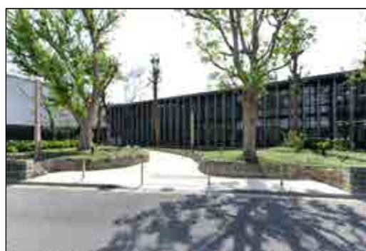
本館北側（建物本来の美しさを引き出すため、植栽を整理し、遊歩道・庭園灯を設置）
