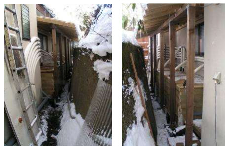
排湯槽設置後
