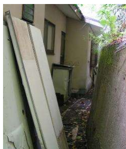
排湯槽設置前
