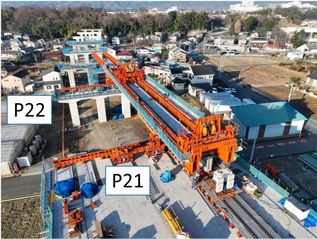
P21～P22 径間の桁をかけています（令和5年1月撮影）
