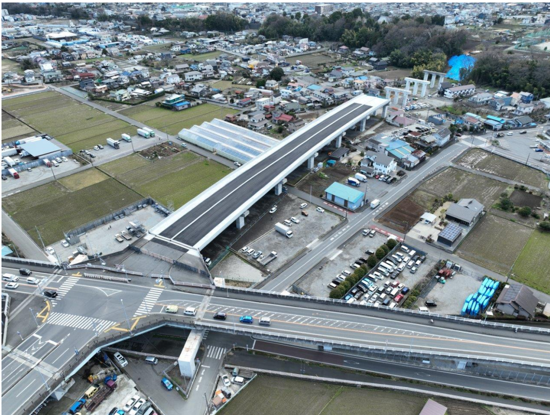
高架工区 全景（航空）写真 中津川から望む（令和6年5月撮影）
