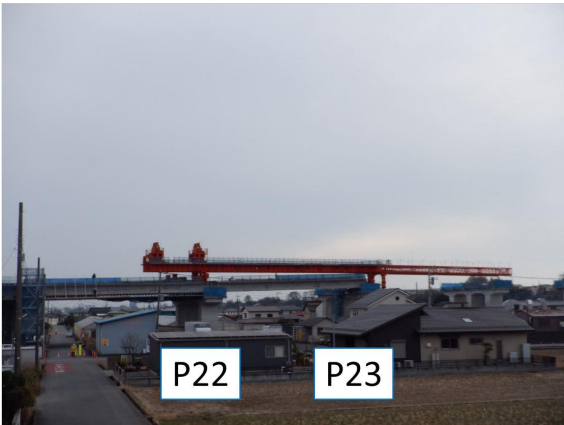
P22～P23 径間の桁をかけています（令和5年2月撮影）
