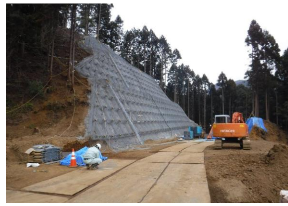
辺室沢橋の起点側橋台付近 (令和2年8月頃)
