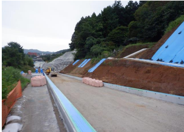
起点側交差点とユズナ沢橋の間 (令和4年9月頃)
