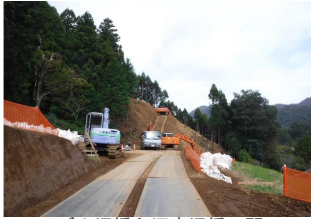
ユズナ沢橋と辺室沢橋の間 (平成30年10月頃)
