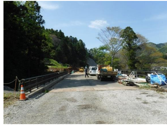
ユズナ沢橋付近
