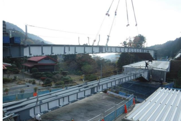
辺室沢橋の桁架設(令和2年11月頃)
