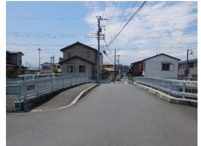
天神橋 (架替え後)
