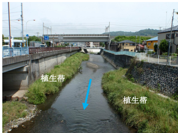
親木橋上流(現況)
