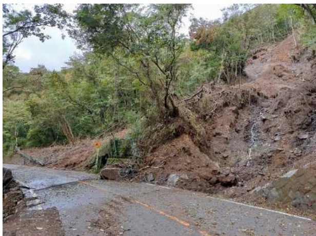
○国道 138 号線(箱根) 土砂崩れによる車両通行止め
