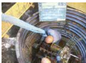
公共下水道の整備
