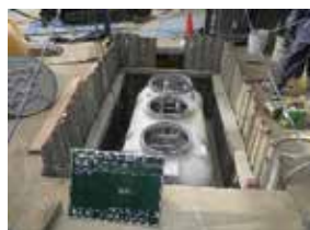
一般家庭への浄化槽設置
