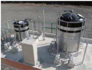
山梨県大月市にある桂川清流センター内に、凝縮材によるリン除去設備を設置した。
