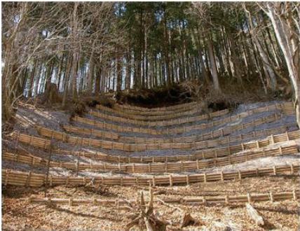
土壌流出防止対策実施後の様子。林地崩壊の防止が図られ、やがて植生の回復が期待できる。
