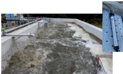
スマート技術を取り入れた浄化槽のばっ気制御技術の開発
