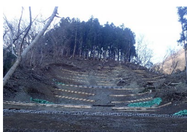
水源林の基盤整備
