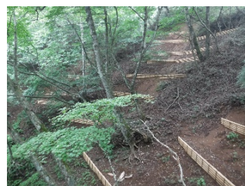
中標高域の自然林の土壌保全対策
