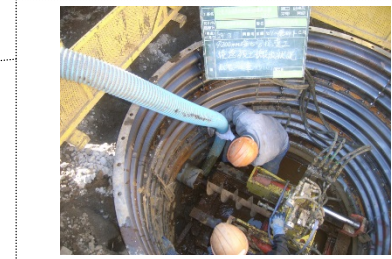
⑧生活排水処理施設の整備促進(下水道・浄化槽) 推進工法(道路を開削せず、トンネル状に掘削した穴に管を通す工法)により管を敷設した。(相模原市緑区)
