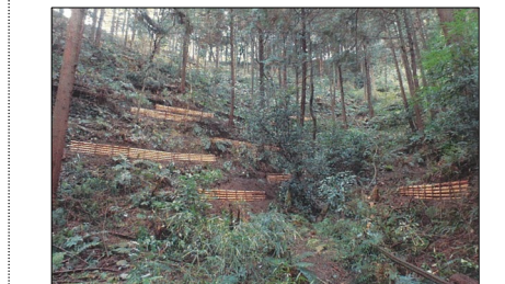
⑤地域水源林整備 整備協定で施策を行ったスギ・ヒノキの人工林および広葉樹林で目標林型を混交林として間伐や土壌保全のための丸太柵設置を行った。(山北町浅間山)
