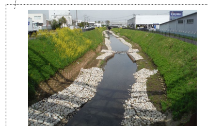
⑥河川・水路における自然浄化対策 自然石による護岸とし、生物の生息空間を確保した。(厚木市恩智川)
