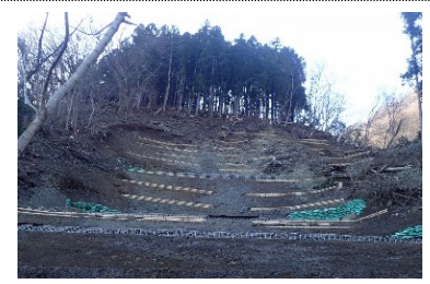
③土壌保全対策 水源林の基盤整備では土木的工法を用いて土壌保全対策を実施した。(山北町世附)
