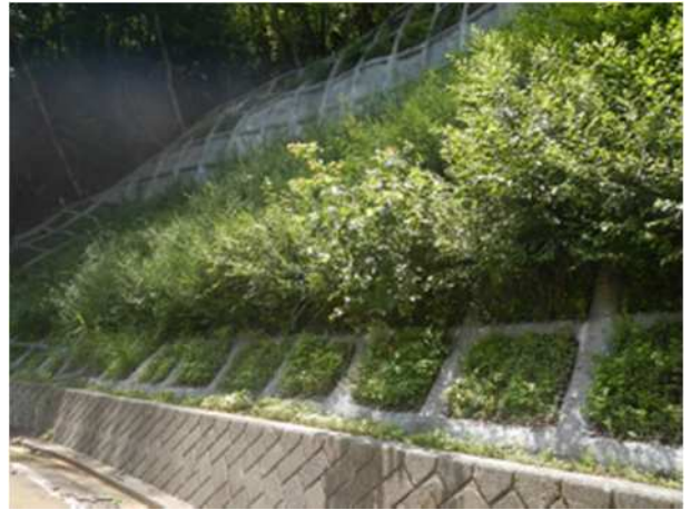
○無種子客土吹付工施工3年後の自生種定着状況 [相模原市]
