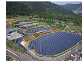
湘南ベルマーレ 愛川太陽光発電所
