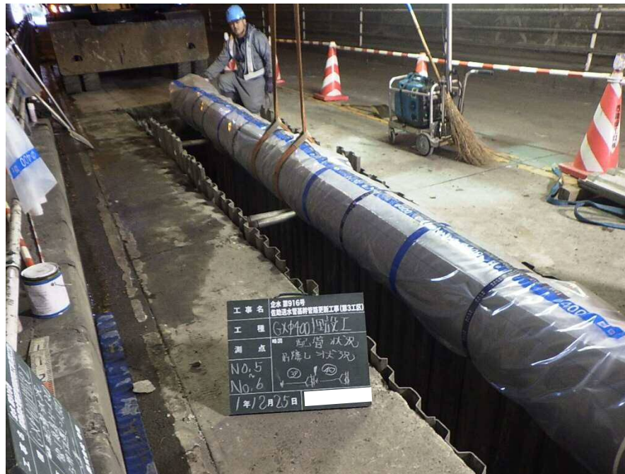
鎌倉市佐助地内送水管基幹管路更新工事 耐震継手管埋設工の様子
