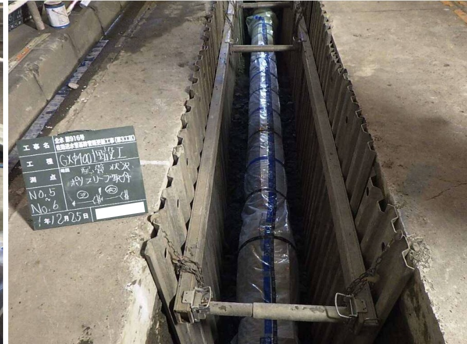
鎌倉市佐助地内送水管基幹管路更新工事 耐震継手管埋設工の様子
