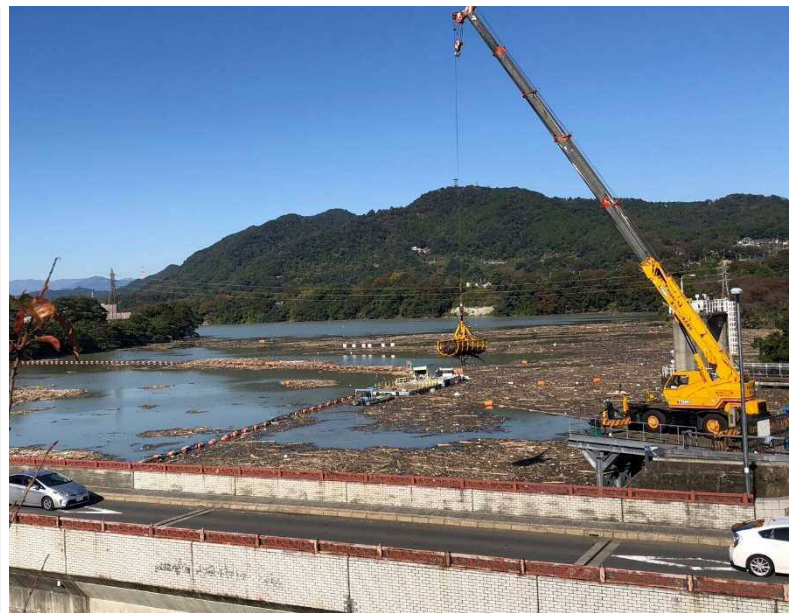
城山ダム流芥処理工事の様子
