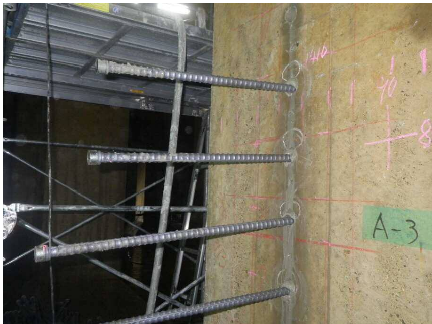
平塚配水池（平塚市）内部の柱に鉄筋を挿入して補強している様子
