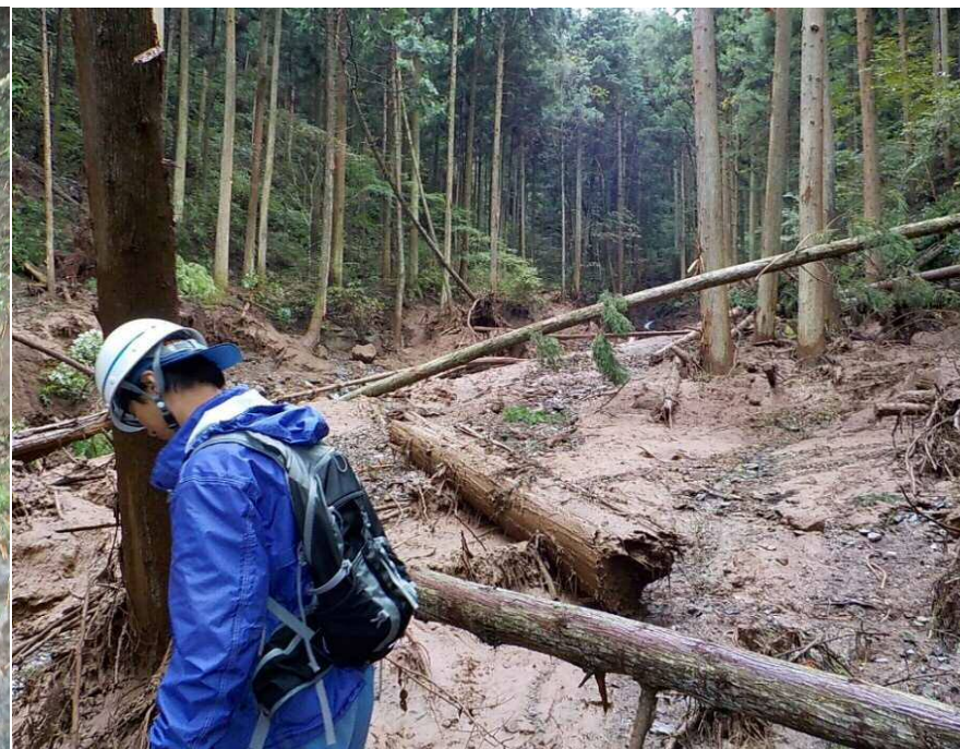
埋没した取水口 (底沢浄水場)
