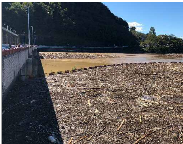
城山ダム流芥の様子 (R1.11.8時点)
