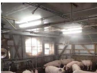
写真2 換気扇直前での散水の様子
