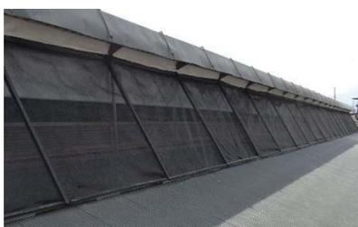
写真1 豚舎開口部の遮光ネット設置状況
