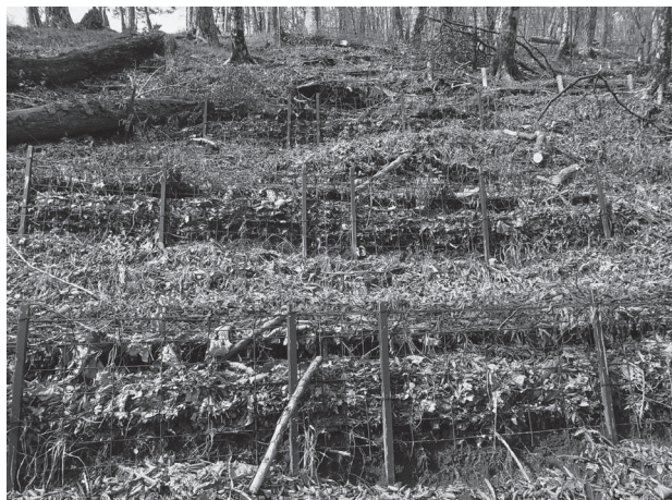
写真3 金網筋工
