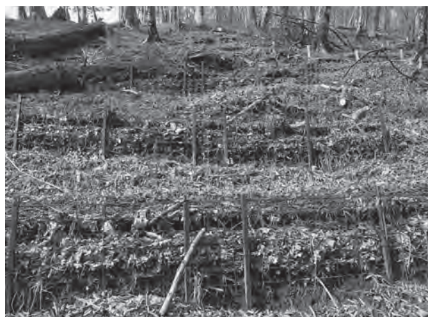
写真3 金網筋工
