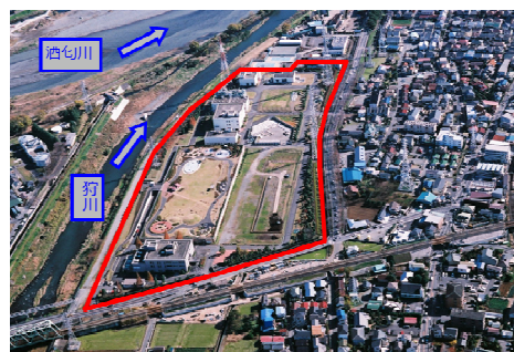
扇町水再生センター (小田原市扇町)
