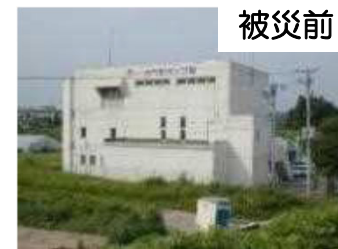
ポンプ場の被害状況
