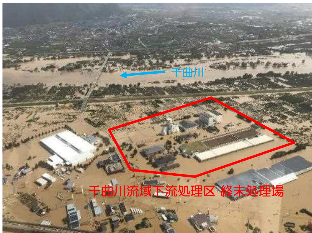
下水処理場の被害状況
