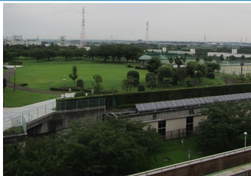
相模川流域下水道四之宮水再生センター
