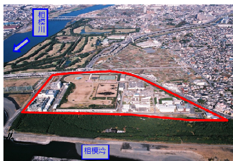
柳島水再生センター (茅ヶ崎市柳島)
