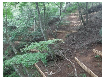
中標高域の自然林の土壌保全対策
