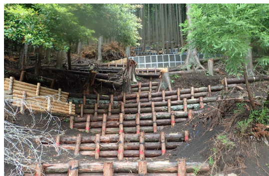
復旧対応後の様子（土壌侵食防止工）
