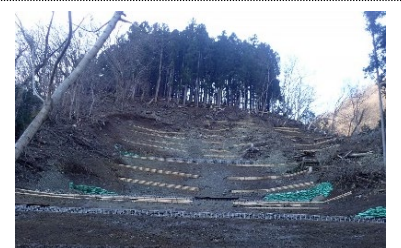
③土壌保全対策 水源林の基盤整備では土木的工法を用いて土壌保全対策を実施した。(山北町世附)
