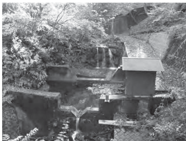
写真1 現在の量水堰（2013.11撮影）
