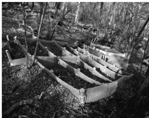
写真1 リター捕捉ネット工
