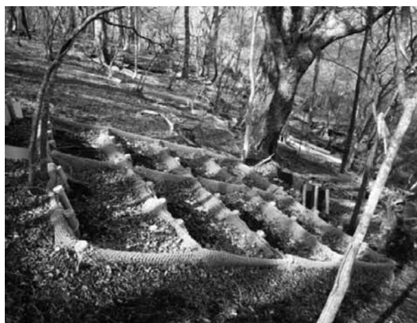
写真2 リターロール工（タイプB）
