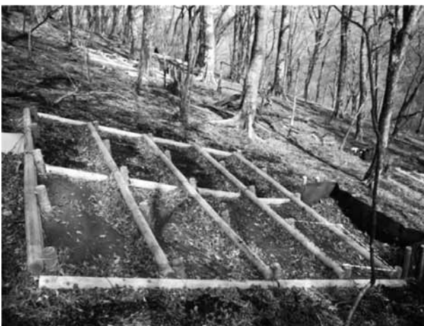
写真4 木製筋工+ネット伏工（竹繊維ネット）
