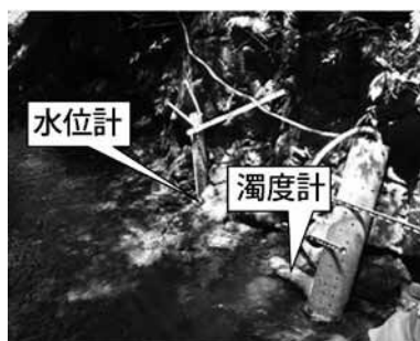
写真2 堂平沢に設置した水位計、濁度計
