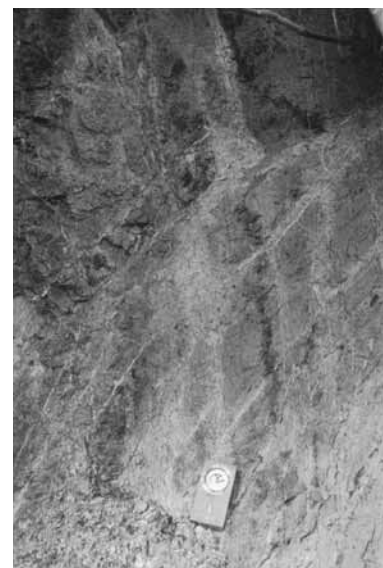
写真5 A沢左岸（調査孔下）の露頭（③付近） (節理：N60° E、90°と小断層)
