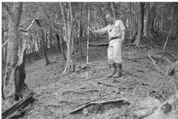
写真1 ヌタノ沢の林床の状況 (土壌が浸食され、根が露出している)
