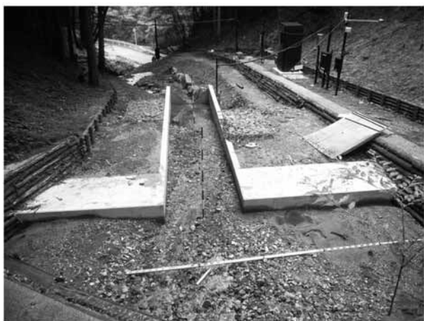
写真5 ヌタノ沢のA沢の量水堰の土砂の堆積状況 (平成23年7月28日撮影)
