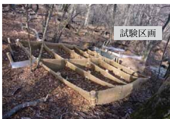
左：リターネット補足工 右：リターネットロール工 東京農工大学撮影（H 22）
