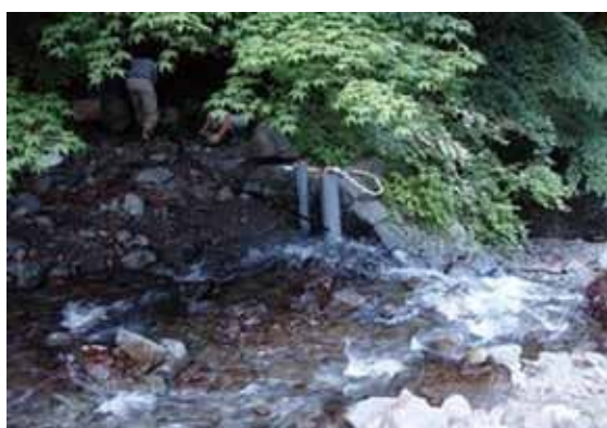
左：既設堰堤の上流の水位計・濁度計設置状況（ワサビ沢）東京農工大学撮影（H 21）
