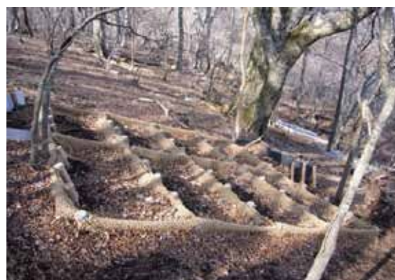
左：リターネット補足工 右：リターネットロール工 東京農工大学撮影（H 22）
