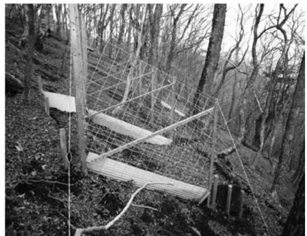
写真5 急斜面用植生保護柵工
