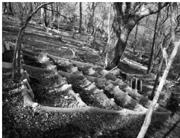
写真2 リターロール工（タイプB）
