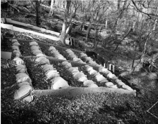
写真3 リター捕捉土嚢工（麻袋）
