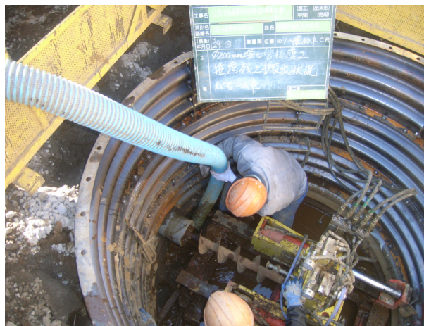
公共下水道の整備 (相模原市)
