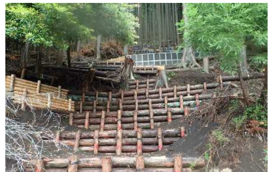
復旧対応後の様子 (土壌侵食防止工)
