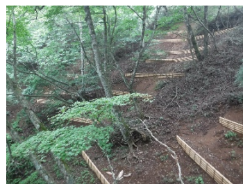
中標高域の自然林の土壌保全対策
