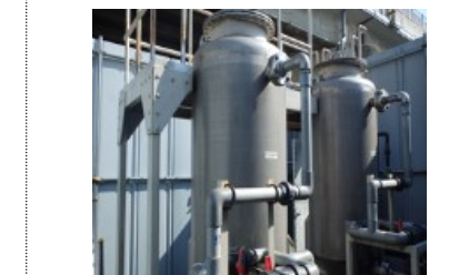
⑦地下水保全対策 有機塩素系化学物質により汚染された地下水を施設の装置に通すことにより水質浄化を図った。(秦野市)
