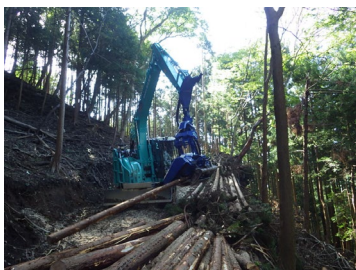
高性能林業機械を利用した 集材・搬出作業の様子
