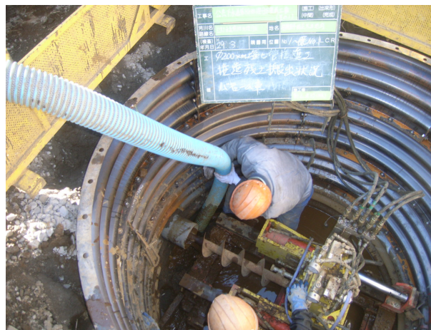
公共下水道の整備 (相模原市)
