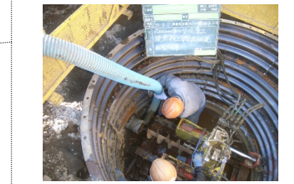
⑧生活排水処理施設の整備促進(下水道・浄化槽) 推進工法(道路を開削せず、トンネル状に掘削した穴に管を通す工法)により管を敷設した。(相模原市緑区)
