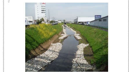
⑥河川・水路における自然浄化対策 自然石による護岸とし、生物の生息空間を確保した。(厚木市恩曾川)
