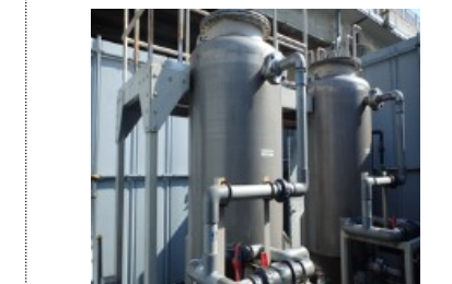
⑦地下水保全対策 有機塩素系化学物質により汚染された地下水を施設の装置に通すことにより水質浄化を図った。(秦野市)
