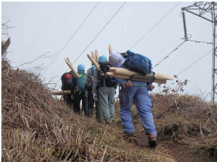
●今回は杭を使わずに丸太を直接埋め込む方法を採用しました。使う資材が少なくなる分、丸太を余分に運べます。
