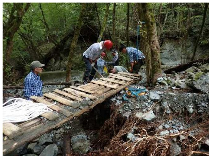
●木橋が安定しているか実際に歩いて確認し、周囲を整えます。最後は再び増水した時に、木橋が下流まで流されないよう木橋の片側と木をワイヤーで繋いで、掛け直し完了です！
