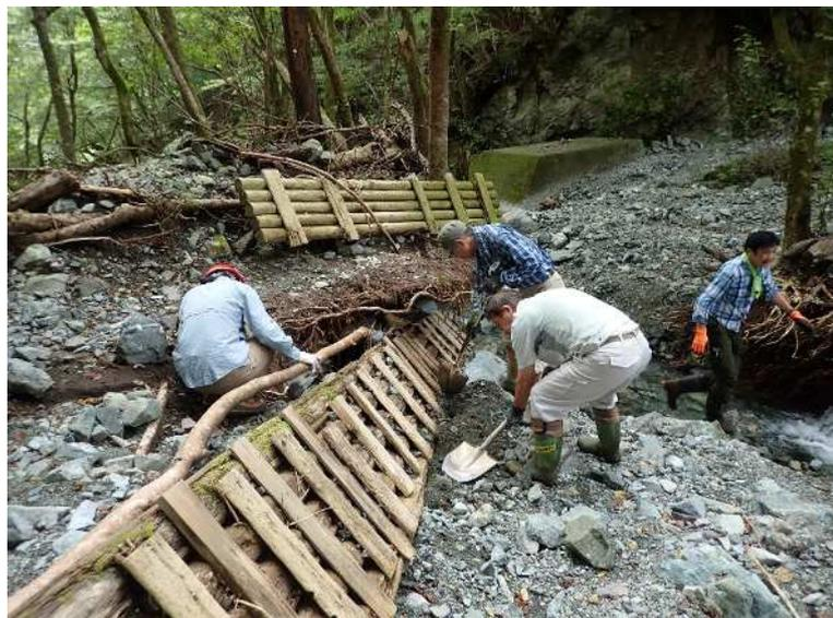
●総勢 7 人の力を合わせて木橋を持ち上げたり、手動ウィンチで何度も引っ張る方向を変えながら、少しずつ段階的に木橋を動かしていきます。
