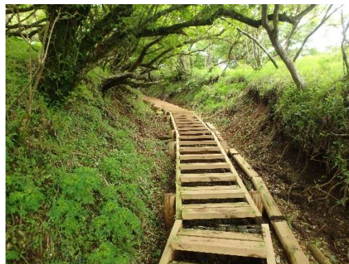
構造階段設置後の様子（2022年6月撮影）
