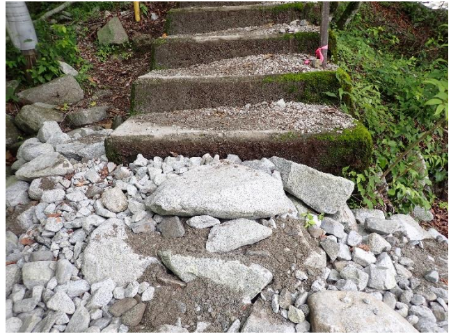
作業後（段差解消！）
