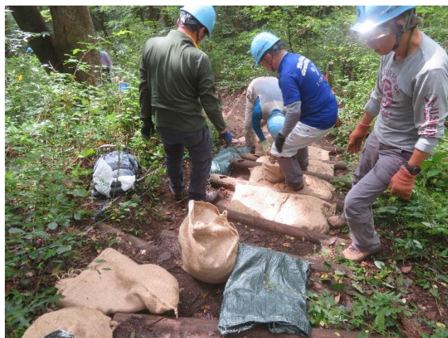
段差解消時の様子
