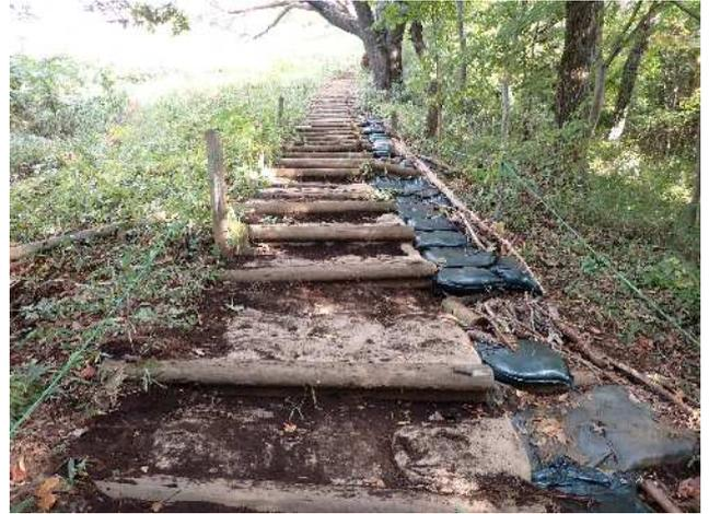
●皆さんの手際がよく、ずいぶん早く補修予定範囲の作業が終了です。残った時間でさらに上部の補修をしました。切れたロープも結びなおし飛び出た鉄筋杭を打ち込みます。
