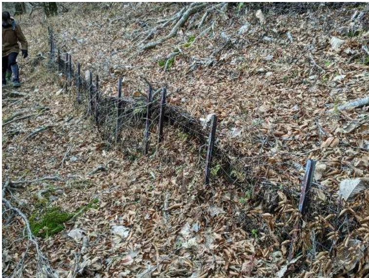
金網筋工に堆積した土壌と落ち葉
