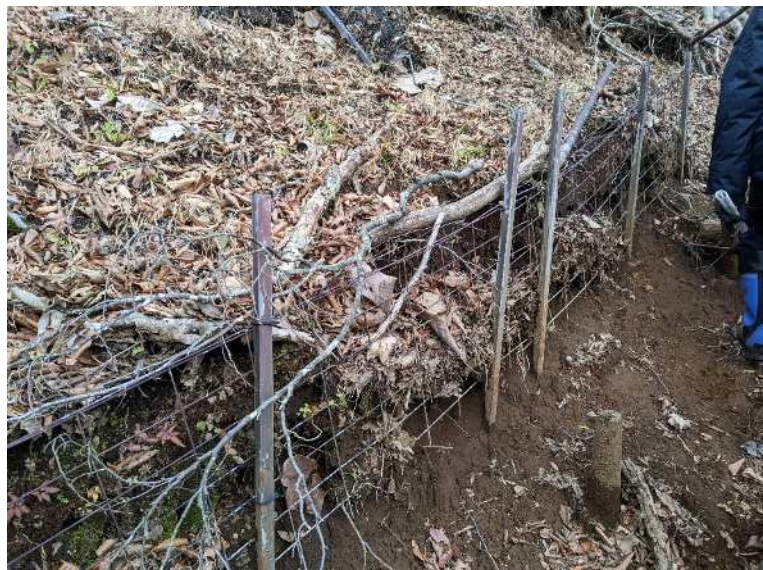
金網筋工に堆積した土壌と落ち葉
