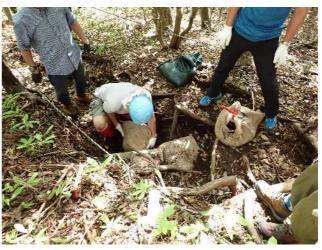
●それ以外のグループの方々は丸太階段を作りました。仮置きして確認した要補修箇所に、杭を打ち込んで固定します。土のうも協力して作っておきます。
