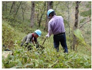
●水切り設置が難しい場所なので石を利用しました。土は止め、水は勢いを落として流すため の工夫です。傾斜地での石運びは力を要する作業です。
