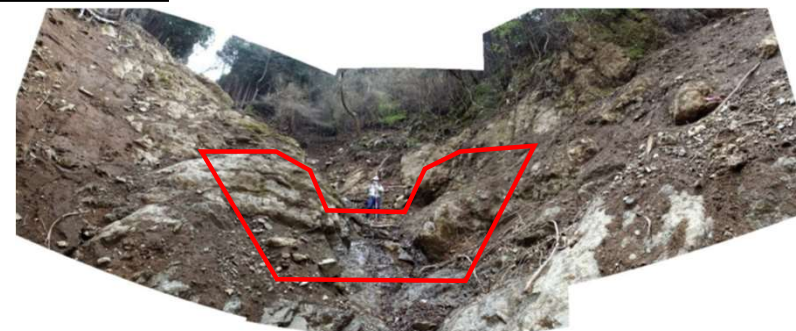
谷止工施工予定地
