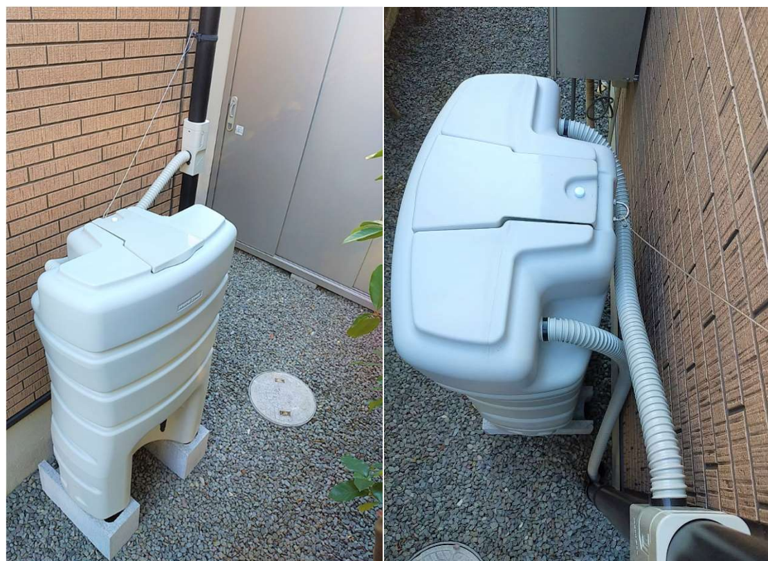
雨水貯留槽設置例（容量：140L）
