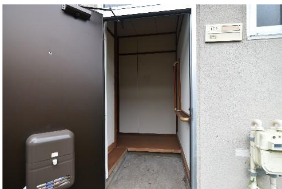
玄関 (I街区6-16棟5号室。以下同じ)
