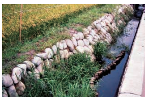
⑤多自然型用水路(伊勢原市)
