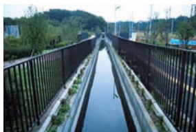
③整備された用水路(茅ヶ崎市)
